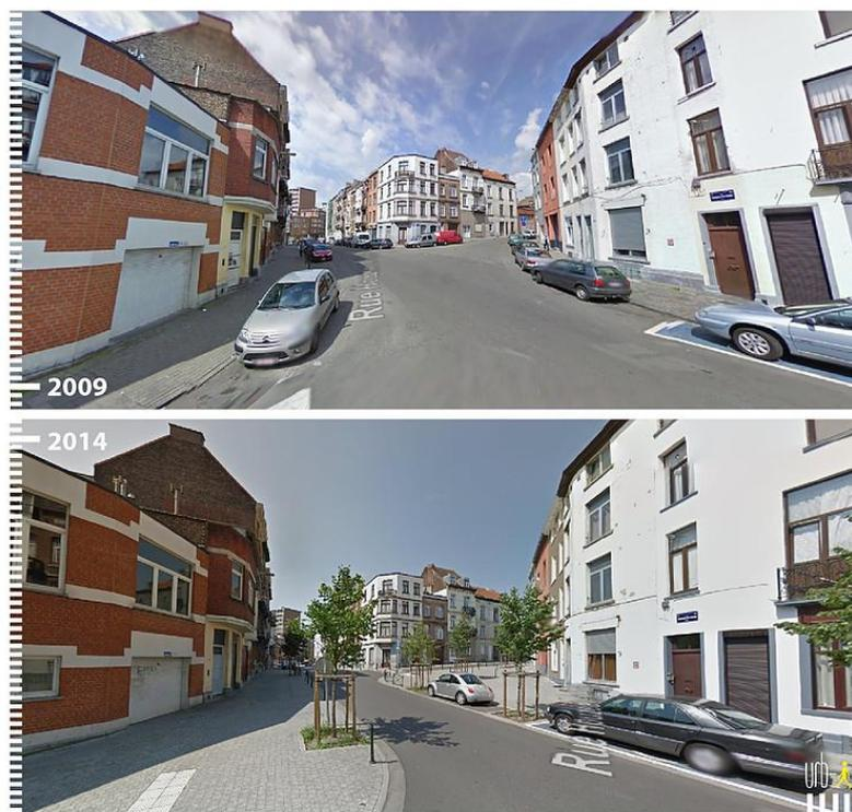
Figure 34 – Entrée en zone 30, effet de porte (plateau) et rétrécissement du carrefour de la Rue Théodore Roosevelt, à Schaerbeek - Exemple de bonne pratique (Source : Before/After Gallery)
