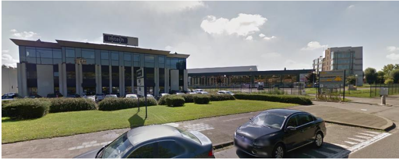
Afbeelding 78: GSI in Anderlecht (Industrielaan) (Bron: Google Street View)
