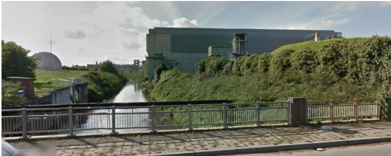
Afbeelding 79: GHV in Haren (Budasteenweg, site van het zuiveringsstation van Brussel-Noord) (Bron: Google Street View)
