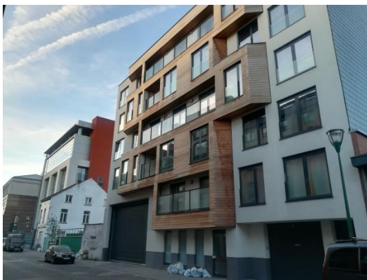
Afbeelding 60: Gedeeltelijk uitspringende gevel met houten bekleding, Opzichterstraat, Sint-Jans-Molenbeek (ABO)
