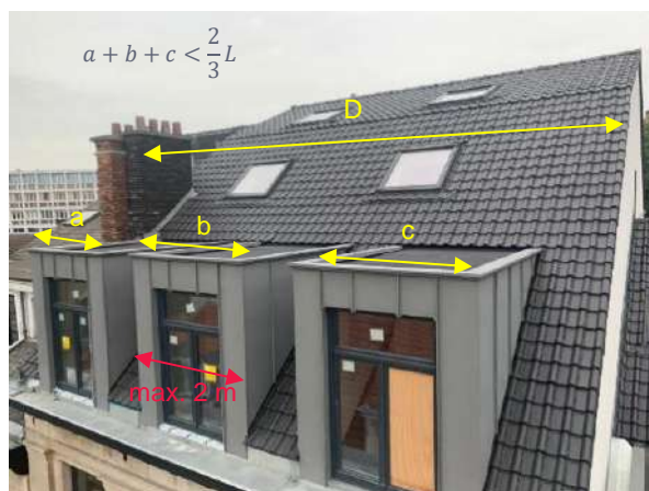
Figuur 170: Illustratie van de bepalingen van § 2 van artikel 19 (Bron: https://www.thomastoitures.be/newthomastoitures/toiture-zinc-plateforme-lucarne )
