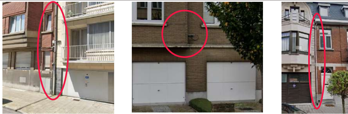
Figuur 171: Zichtbare netten in de gevels van de Adolphe Lacomblélaan te Schaarbeek, de Georges Bergmannlaan te Elsene, de Corneille De Clercqstraat te Jette (Bron: Google Maps)
