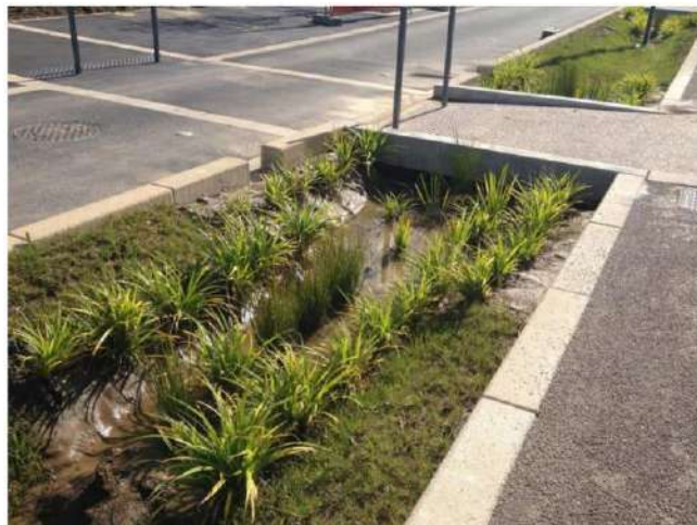
Figuur 121: Voorbeeld van infiltratiegeulen in een openbare ruimte (Bron: Actualisation du PCDN de Liège, gegevensfiche "Noues")
