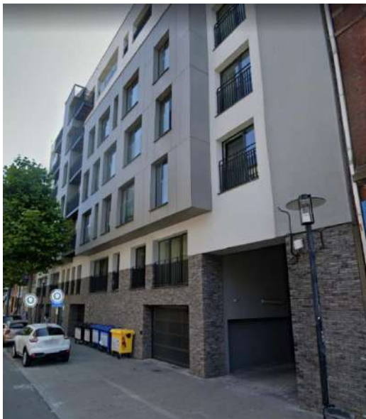
Figuur 167: Voorbeeld van uitwendige isolatie met verschillende parementen (dekplaten, bepleistering, gevelbekleding) (Bron: Google Maps)
