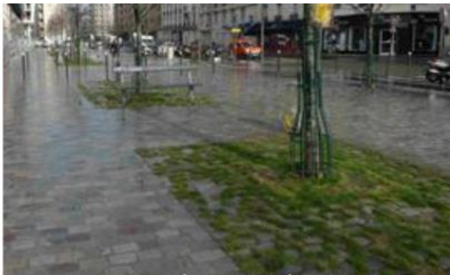
RUE CARDINET : REVÊTEMENT PERMÉABLE EN PIED D'ARBRE.
