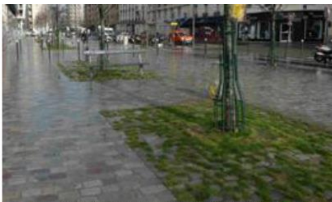
RUE CARDINET : REVÊTEMENT PERMÉABLE EN PIED D'ARBRE.
