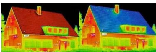
Un toit avant (rouge) et après (bleu) isolation : diminution des pertes de chaleurs et économie d'énergie
