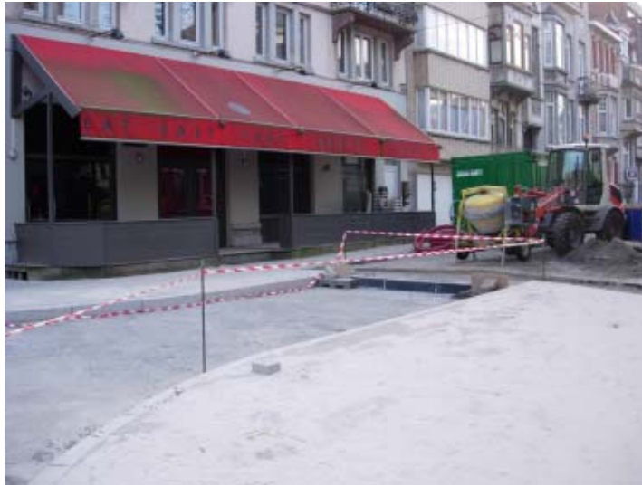
Aanleg van een sas aan de ingang van de zone 30 'René Gobert' – januari 2006
