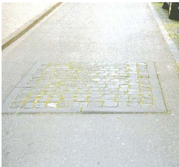
Voorziening van het type 'rijbaankussen'. Bron: Code de bonne pratique des aménagements cyclables", MET 2000 (Franstalig handboek voor aanleg fietsvoorzieningen)
