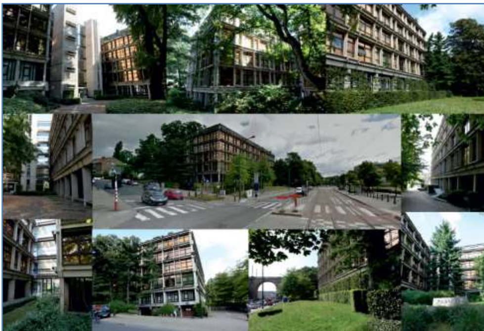
Le projet « U » dans son état initial, proche de l'Ukkelbeek rue de Stalle, service Rénovation urbaine
