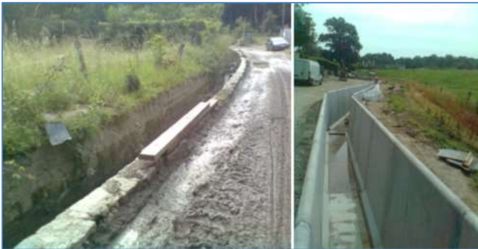
Le Verrewinkelbeek avant et après travaux, service de la Voirie
