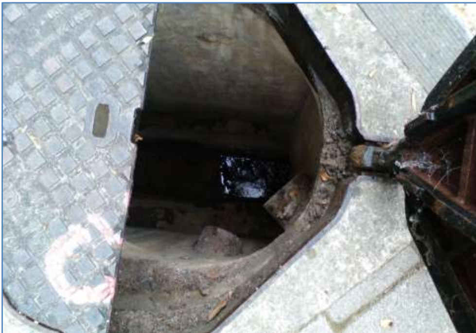
Chambre de visite de l'Ukkelbeek, octobre 2015
