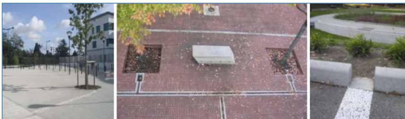
La construction des carrés d'arbres et la gestion des eaux, source Urban Water
