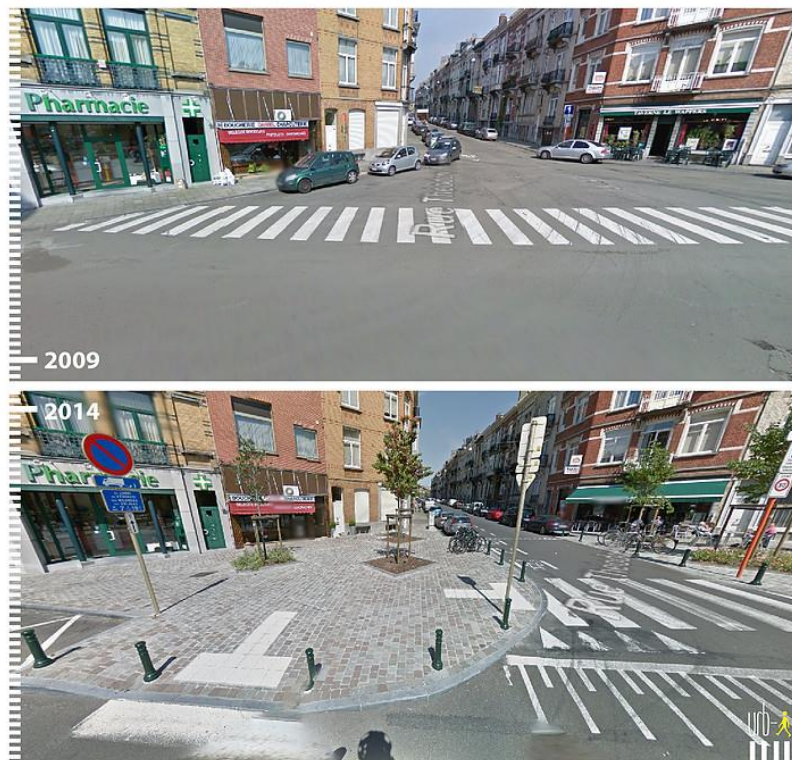
Figuur 34 – Ingang van een zone 30, poorteffect (verkeersdrempel) en wegversmalling van het kruispunt Théodore Rooseveltstraat, in Schaarbeek – Voorbeeld van goede praktijk (Bron : Before/After Gallery)
