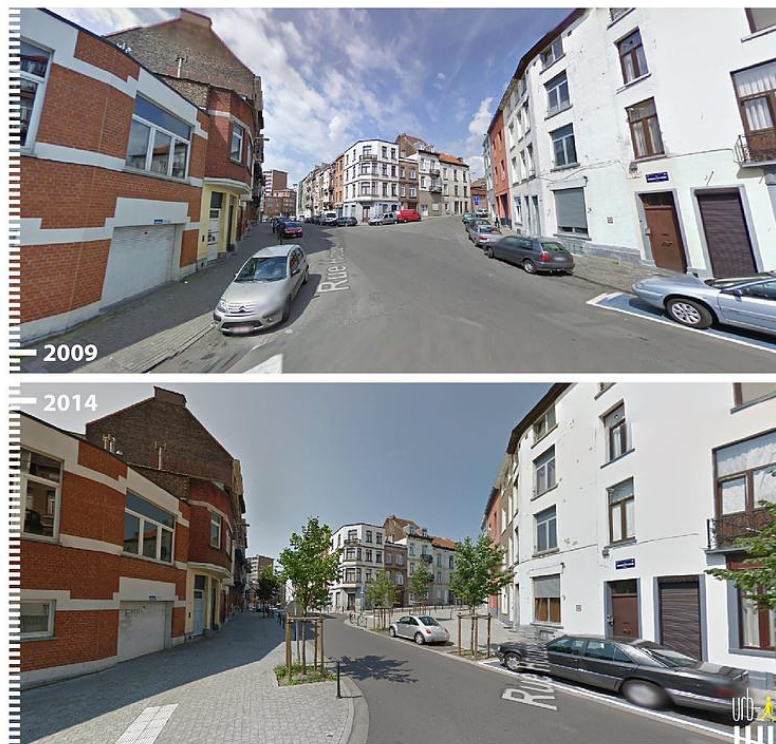
Figuur 33 – Wegversmalling, Houzeaustraat van Lehaie in Koekelberg – Voorbeeld van goede praktijk (Bron : Before/After Gallery)
