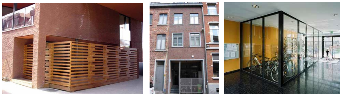
Figuur 42 – Voorbeelden van geïntegreerde fietslokalen in nieuwe woningen of renovaties (Bron: Fiets Suite)
