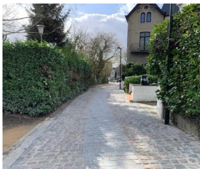
Figuur 27: Rijstrook in gezaagde kasseien in de Vissersstraat – Ukkel
